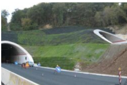
Redes de Proteção com Terramat
