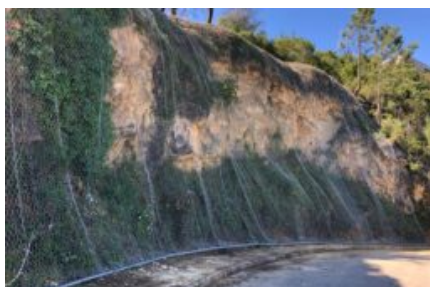
Redes de Proteção
