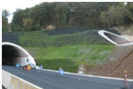
Redes de Proteção com Terramat
