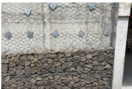
Gabiões de revestimento
