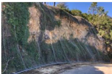
Redes de Proteção
