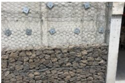
Gabiões de revestimento
