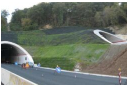
Redes de Proteção com Terramat
