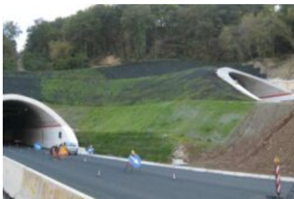
Redes de Proteção com Terramat
