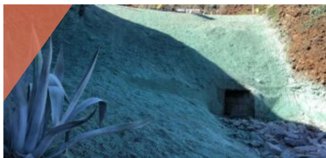
Estabilização de talude na Maia
