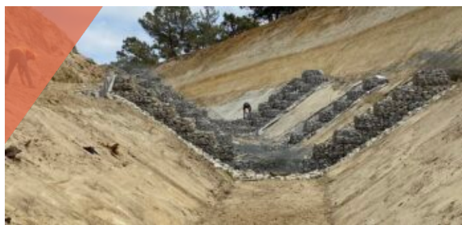
Dissipadores de carga hidráulica em Gabiões
