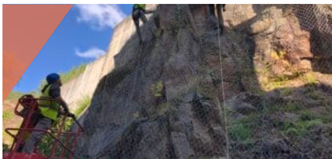
Estabilização de talude na Central Hidroelétrica de Ponte de Jugais
