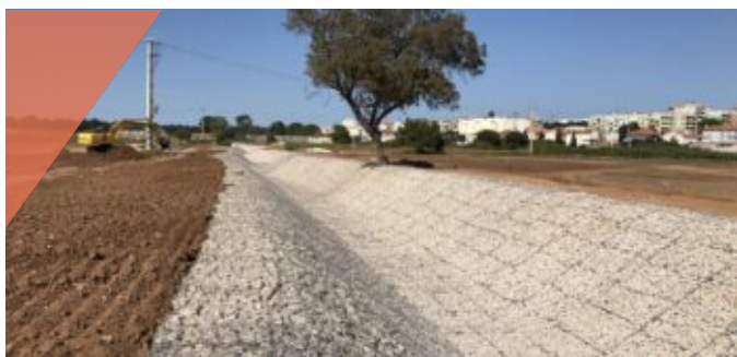
Regularização da Ribeira do Livramento no Parque Urbano da Várzea
