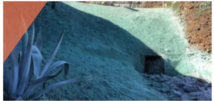
Estabilização de talude na Maia
