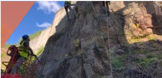
Estabilização de talude na Central Hidroelétrica de Ponte de Jugais
