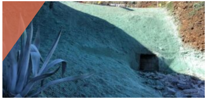
Estabilização de talude na Maia
