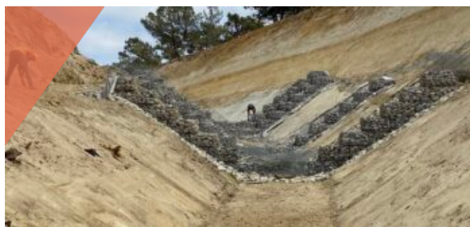
Dissipadores de carga hidráulica em Gabiões
