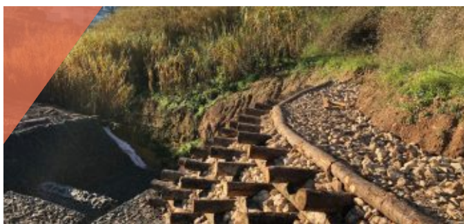
Estabilização de solos e bacias de dissipação hidráulica no Vale da Ameixoeira
