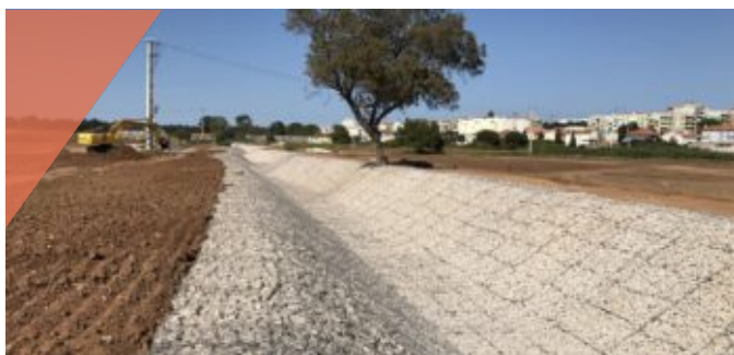
Regularização da Ribeira do Livramento no Parque Urbano da Várzea
