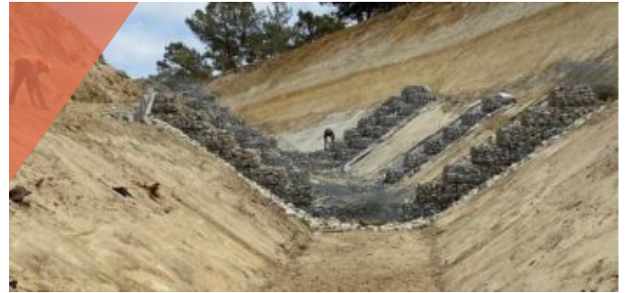
Dissipadores de carga hidráulica em Gabiões
